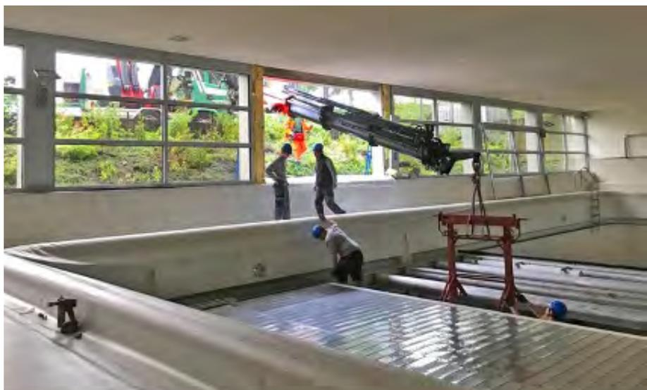
Ersatz des Schwimmkörpers im Hubboden der Schwimmhalle mit unkonventionellen Methoden.
