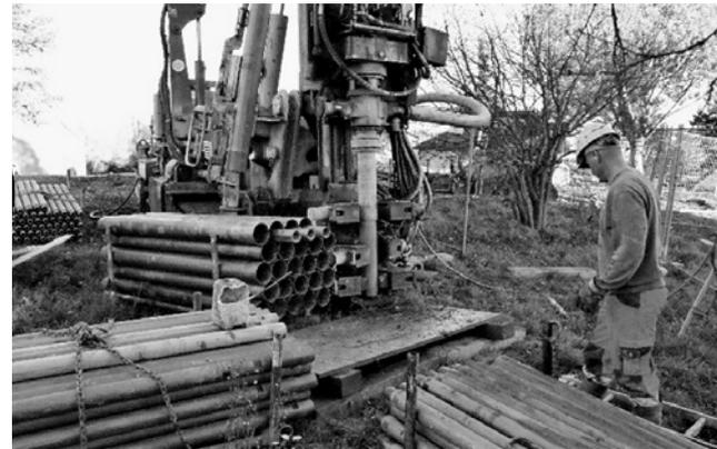
Bohrinstallation für eines von 17 Bohrlöchern
